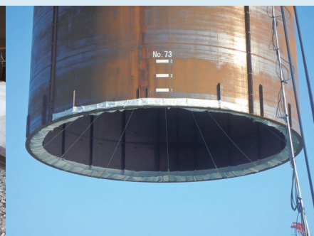
セルの中詰材流出防止事例
