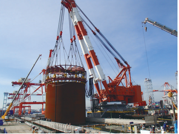
■ 打設方式のセル岸壁構造
