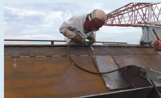
アーキ端部の円周リブの補鋼板（応力集中部の補強）
