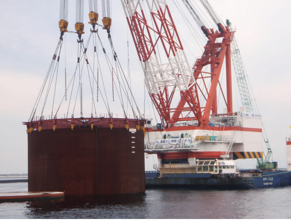
■ 据付方式のセル岸壁構造
